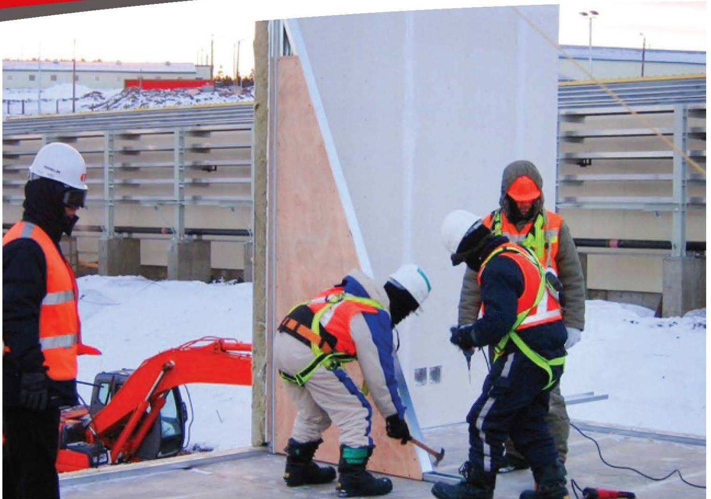
ON SIGHT ASSEMBLY FROM PRE-FAB PANELS PANELEK ÁLLÍTÁSA A HELYSZÍNEEN (2006 JANUÁR)
