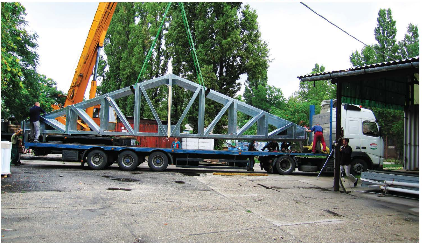
TRANSPORT OF SHIPPING CRATES AND ROOF TRUSSES SZÁLLÍTÓKERETEK ÉS TETŐSZERKEZET SZÁLLÍTÁSA
