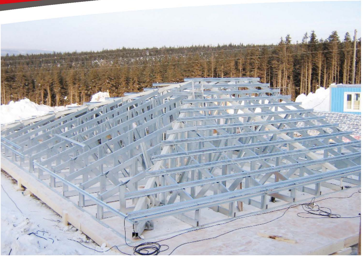
ROOF STRUCTURE PRE-ASSEMBLED | A TETŐSZERKEZET ELŐSZERELÉSE (2006 JANUÁR)
