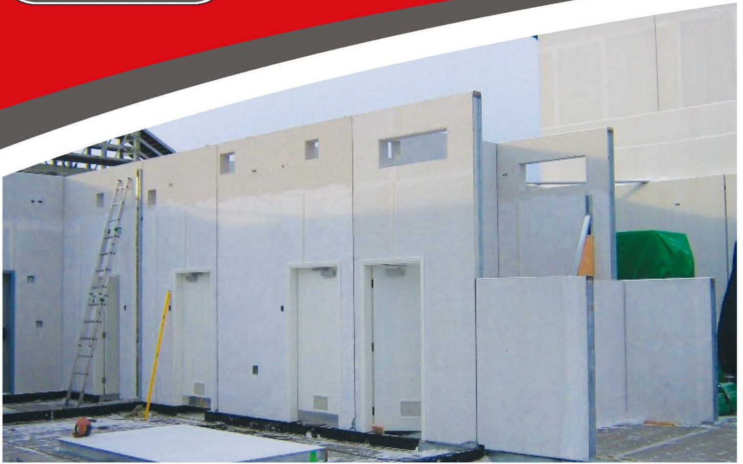
ON SIGHT ASSEMBLY FROM PRE-FAB PANELS PANELEK ÁLLÍTÁSA A HELYSZÍNEEN (2006 JANUÁR)
