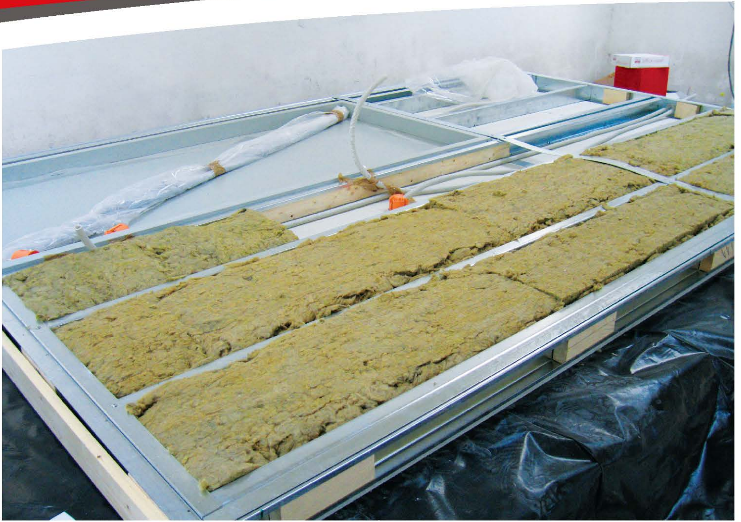
WALL PANELS ASSEMBLY | A FALPANELEK SZIGETELÉSE, KOMPLET BEFEJEZÉSE
