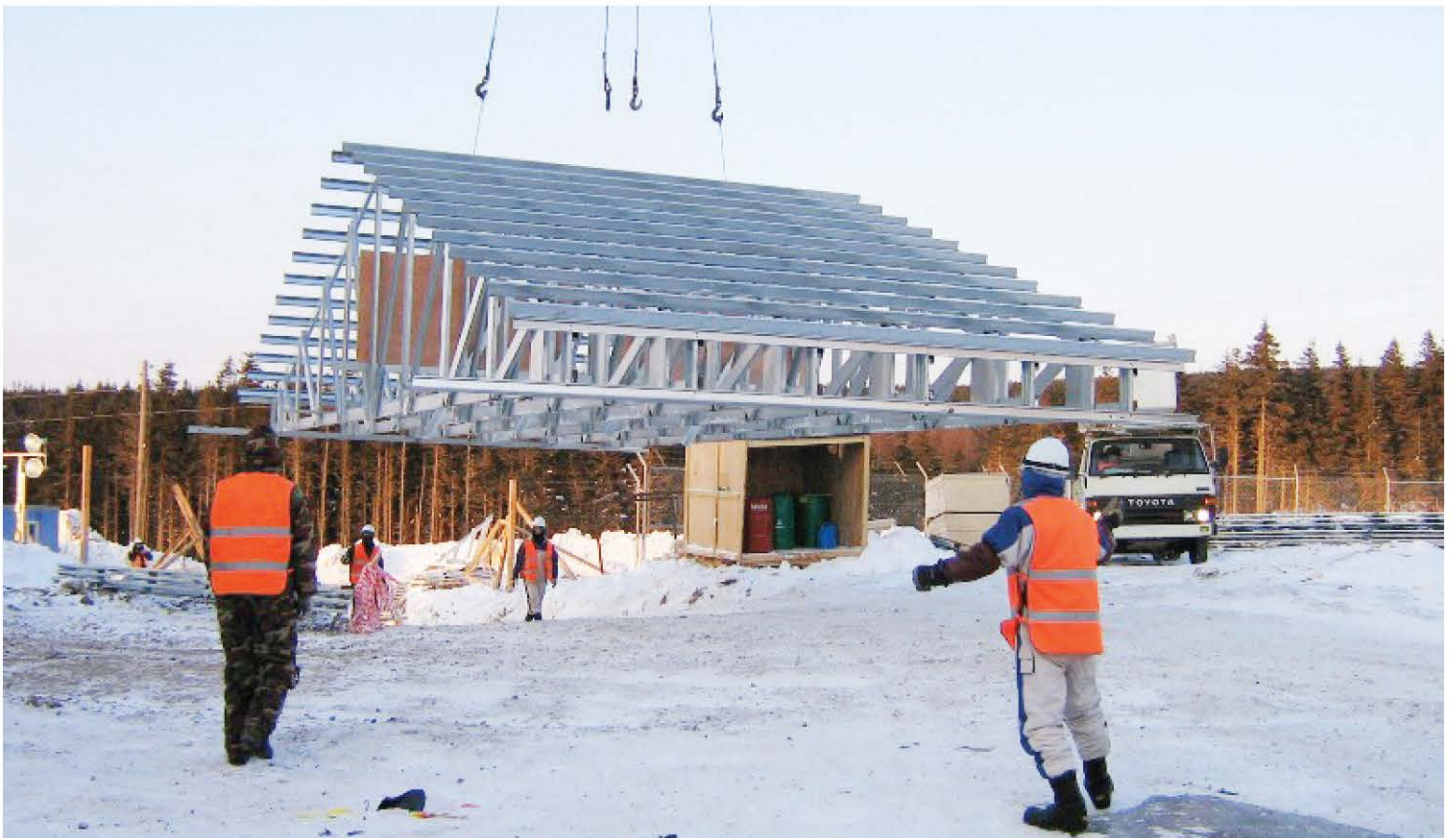
ROOF STRUCTURE PRE-ASSEMBLED | A TETŐSZERKEZET ELŐSZERELÉSE (2006 JANUÁR)
