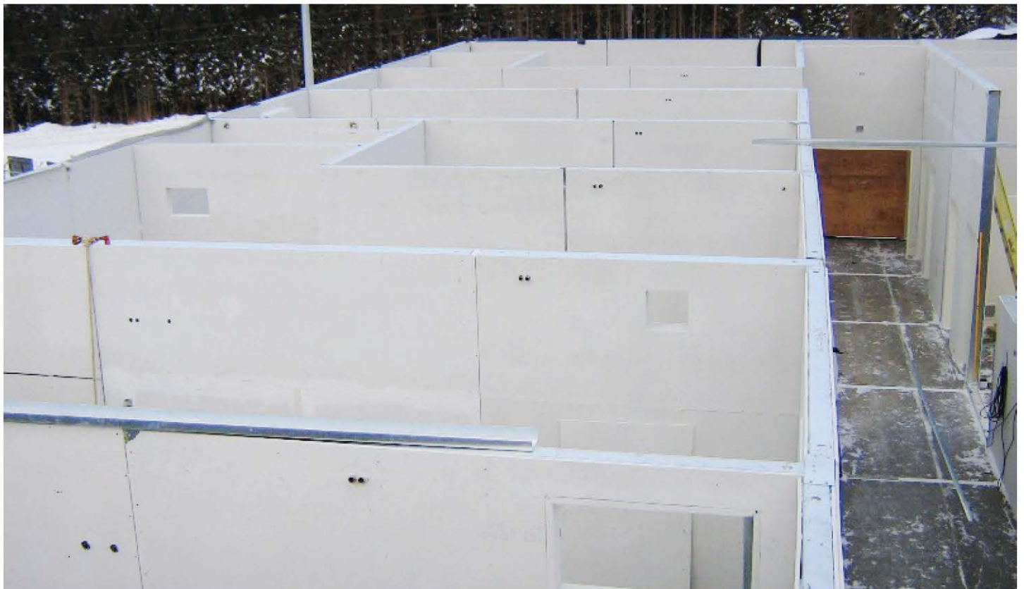
ON SIGHT ASSEMBLY FROM PRE-FAB PANELS PANELEK ÁLLÍTÁSA A HELYSZÍNEEN (2006 JANUÁR)
